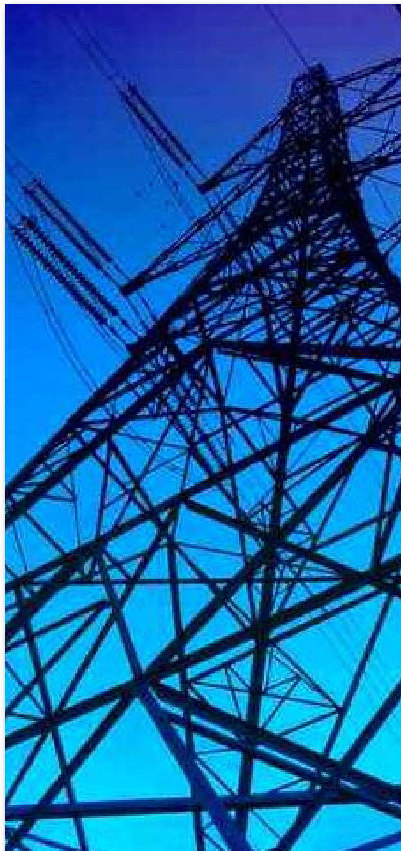
Belastende Hochspannungsleitungen in unmittelbarer Nachbarschaft
